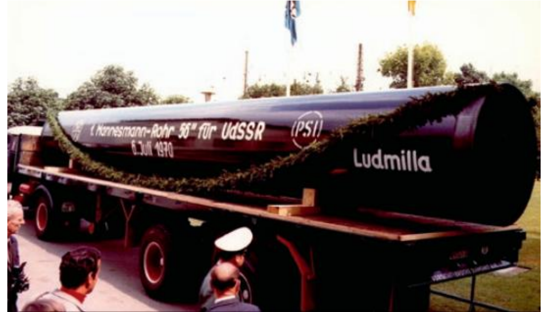
Erste Mannesmann-Rohr „Ludmilla“ für Transgas- Pipeline am 6.7.1970 in Mülheim/Ruhr
