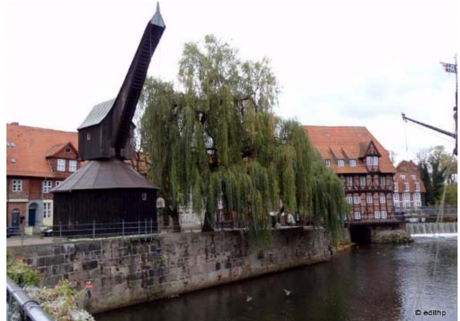
Salzkran in Lüneburg
