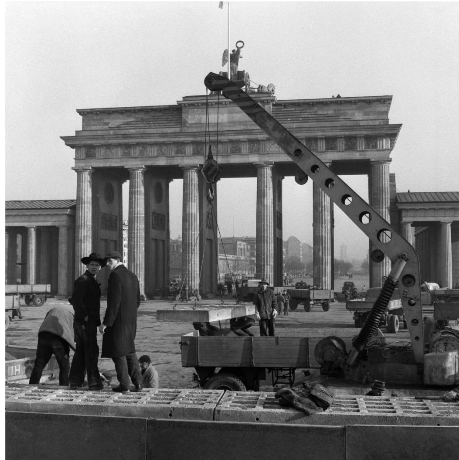
Bau Berliner Mauer am 13.8.1961
