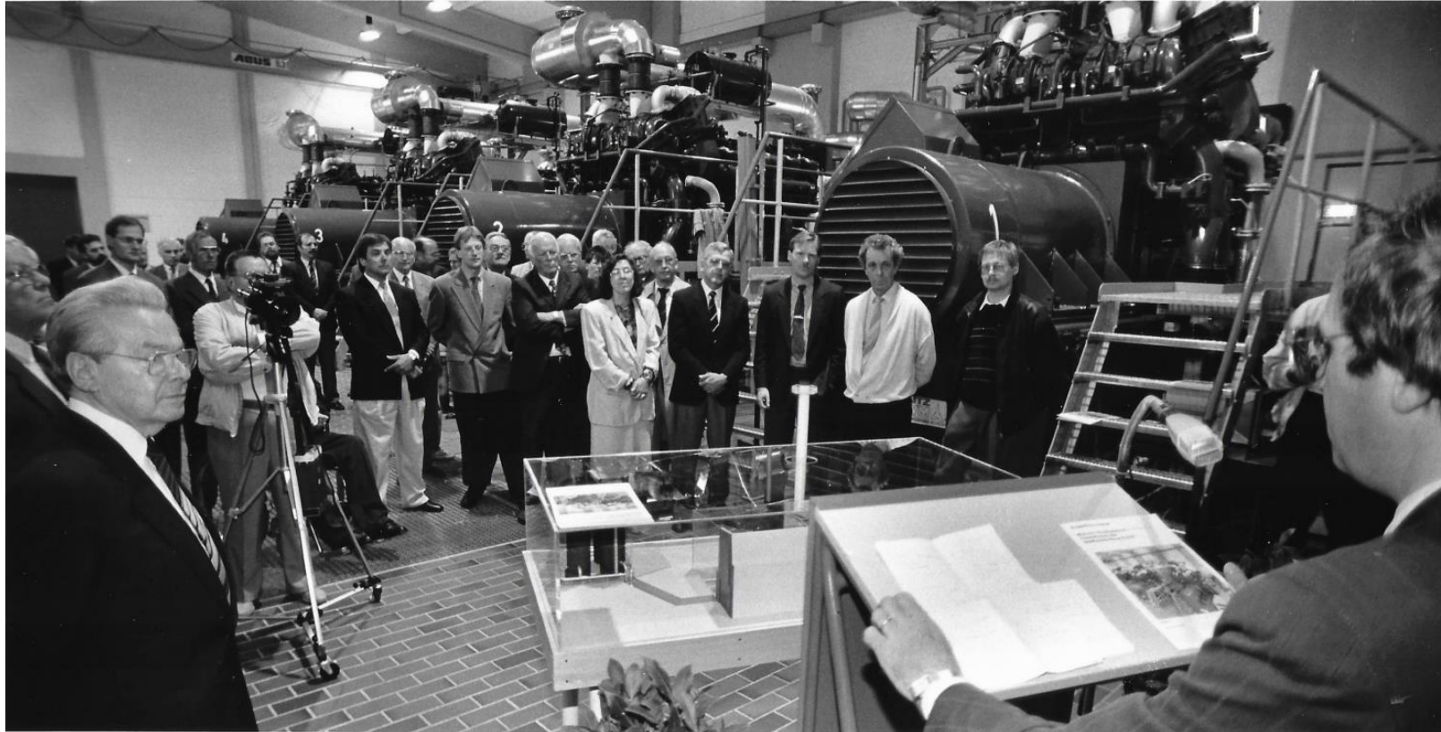
Inbetriebnahme des mit Erdgas betriebenen Blockheizkraftwerks Peine im Dezember 1990
