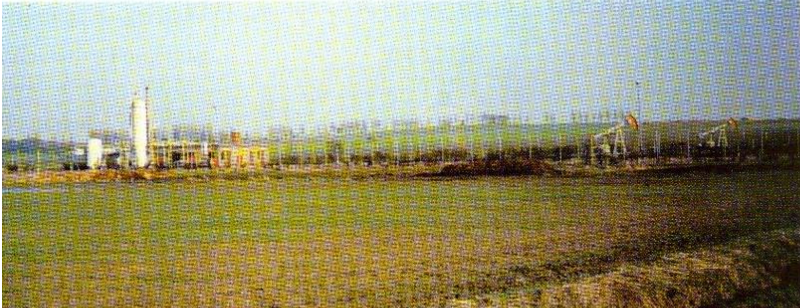
Pilotanlage zur Wiedereinbetriebnahme des Oberger Ölfelds mit neuer Fördertechnik nach der ersten Ölkrise 31.12.1984: Ende der Ölförderung in Oberg
